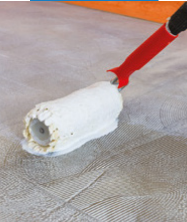
Aplikácia základného náteru Eco Prim T s použitím valčeka
